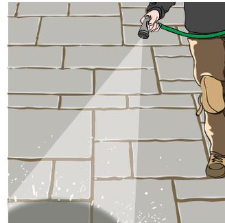
**Besprühen** Sie das Pflaster auf 3 m<sup>2</sup> mindestens 30 Sekunden lang oder so lange, bis GATOR SAND XP G2 das Wasser abstößt und sich das Wasser in den Polymersand-Fugen zu sammeln beginnt.
