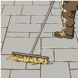
**Kehren** Sie überschüssiges GATOR SAND XP G2 von der Pflasterfläche, zunächst mit einem hartborstigen Besen, dann mit einem weichen Besen. Achten Sie darauf, dass die Fugenfüllung mit GATOR SAND XP G2 bis max. 3 mm unterhalb der Belagsoberfläche reicht.
