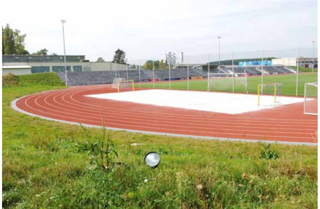
Unzureichende Sicherheitszonen, mangelnde Standsicherheit von Toren und Gefahrenstellen an Zäunen oder Barrieren – die Mängelliste vieler Sportplätze ist lang. Das wurde bei einer FLL-Fachtagung zum Thema Verkehrssicherheit deutlich.
