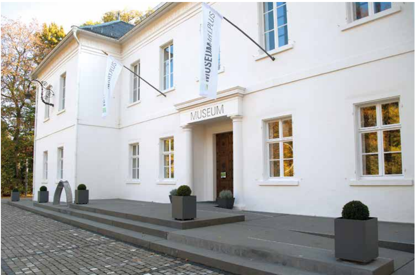
Treppenanlage mit integrierter Rampe (barrierefrei), Artwork SB 251, kugelgestrahlt
