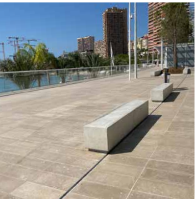
Renovierung Strand Monaco, Frankreich
