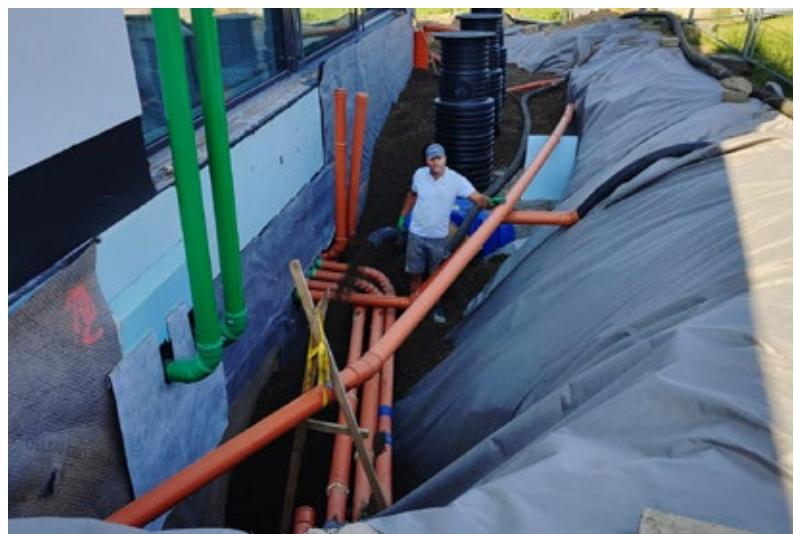
**Verfüllung von Bau-, Arbeits- und Hohlräumen an schwer zugänglichen Stellen mit dem Silo-LKW. Wenn für schweres Gerät wie Radlader und Bagger kein Durchkommen ist, kann das Verfüllmaterial (weit über 100m) eingeblasen werden. Innerhalb kürzester Zeit (je nach Schlauchlänge 1-2 Stunden) sind bis zu 27 cbm Material eingebaut und auch direkt verdichtet.**
