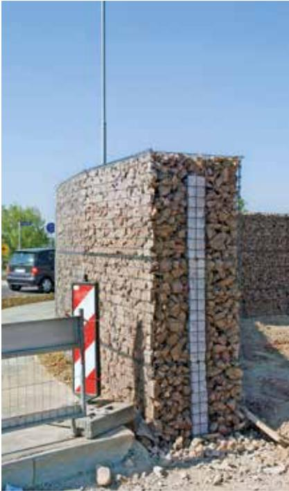
Bei Füllung mit groben Steinen Körnung 63/125 mm, werden schallabsorbierende Eigenschaften erreicht. In Verbindung mit dem Sandkern ergibt sich daraus eine ausgesprochen hohe Schallabsorption.
